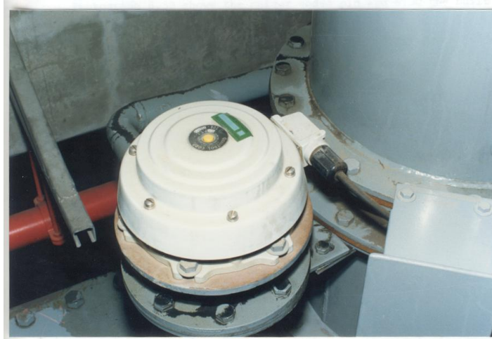
Figura 24: Dispositivo de alivio de la presión
