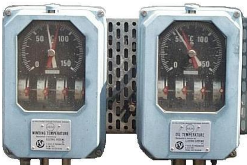
Figura 32: Indicadores de la temperatura de devanado y del aceite En un transformador de potencia de 25 MVA 33 kV / 11 kV
