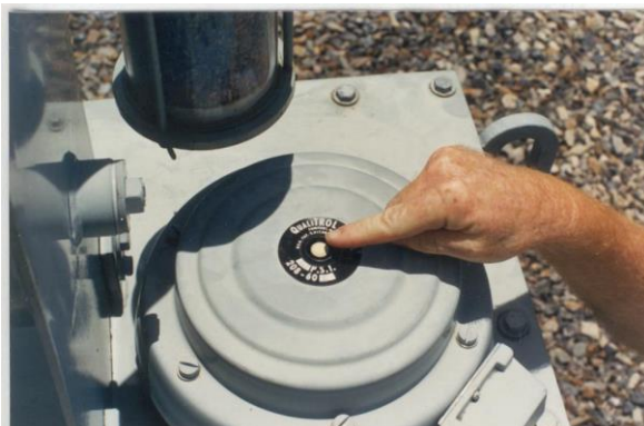
Figura 25: Reseteando el pasador de indicación
