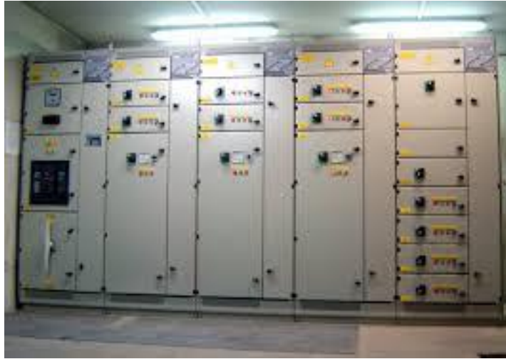
Figura 79 Centro de control de motores
